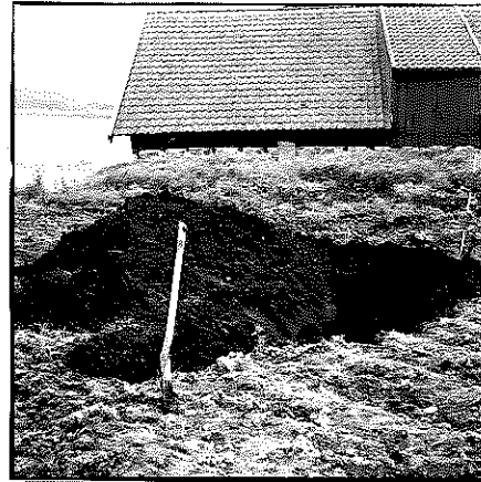
Nr: 4 Schakt S under grävning
